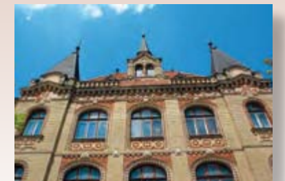
1 903 n.l. Budova školy na Fajnorovom nábr. (SPŠS), Bratislava
